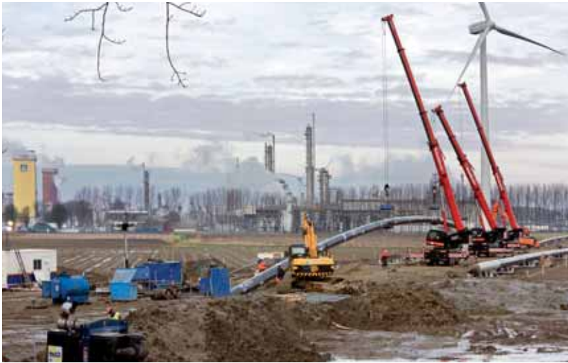
De aanleg van het project WarmCO 2 : restwarmte en restkoolstofdioxide van kunstmestfabriek Yara in Sluiskil worden doorgesluisd naar glastuinders.
